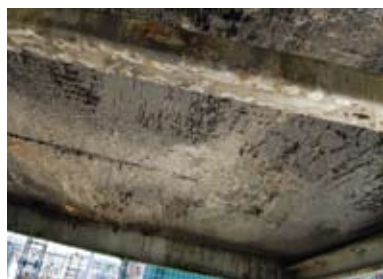
Rys. 8. Kamień wodny i glony niemal całkowicie pokryły lamele
