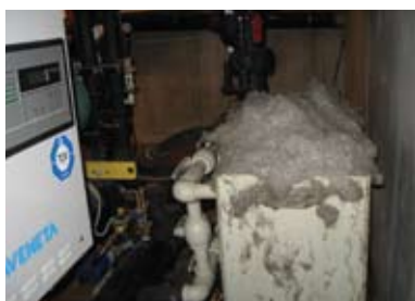
Rys. 12. Reakcja węglanowa podczas czyszczenia skraplacza agregatu CLIMAVENETA – obfita jasna piana
