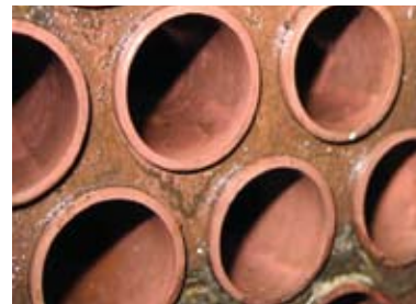
Rys. 19. Stan rurek po 4-godzinnym czyszczeniu 10% roztworem preparatu KAMIX KW
