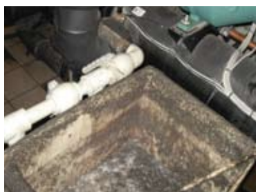
Rys. 13. Koniec reakcji – piana opadła, a roztwór ściemniał i przestał być klarowny. Na ścianach agregatu glony wyniesione przez roztwór
