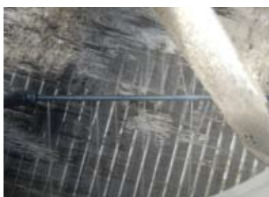
Rys. 14. Sposób natrysku roztworu czyszczącego na lamele – obfita piana świadczy o dużej intensywności reakcji chemicznej
