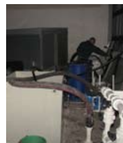
Rys. 10. Przygotowania do czyszczenia instalacji wody lodowej
