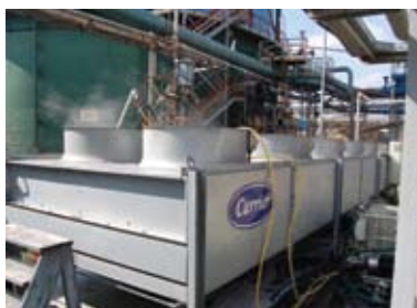
Rys. 9. Taca ociekowa z folii do odbioru natryskiwanej od góry roztworu czyszczącego
