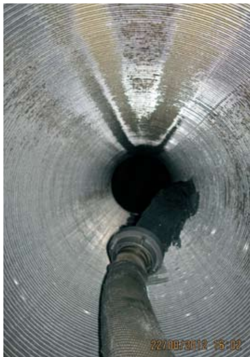
Rys. 19. Płukanie końcowe
