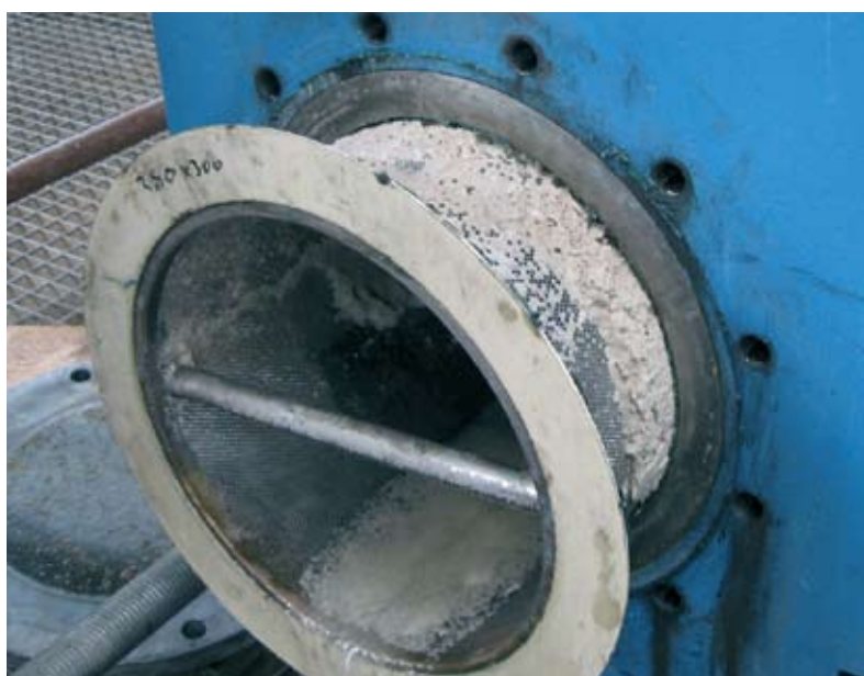
Rys. 17. Demontaż filtra po stronie wody chłodniczej
