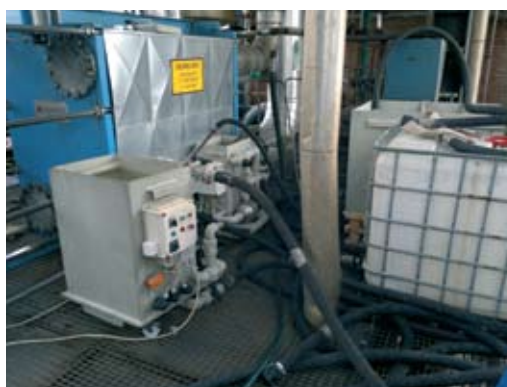
Rys. 10. Podłączenie rurociągów i agregatów czyszczących
