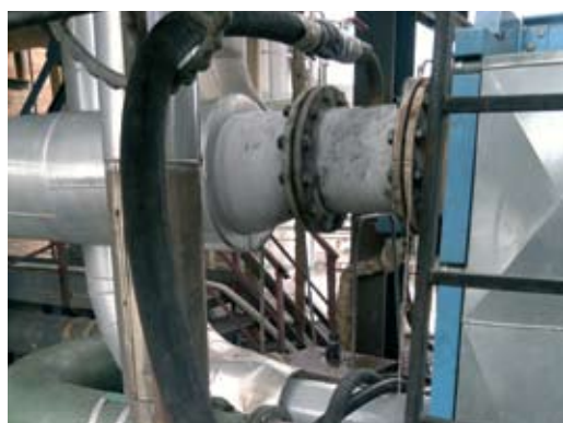
Rys. 9. Wspawanie króćców serwisowych
