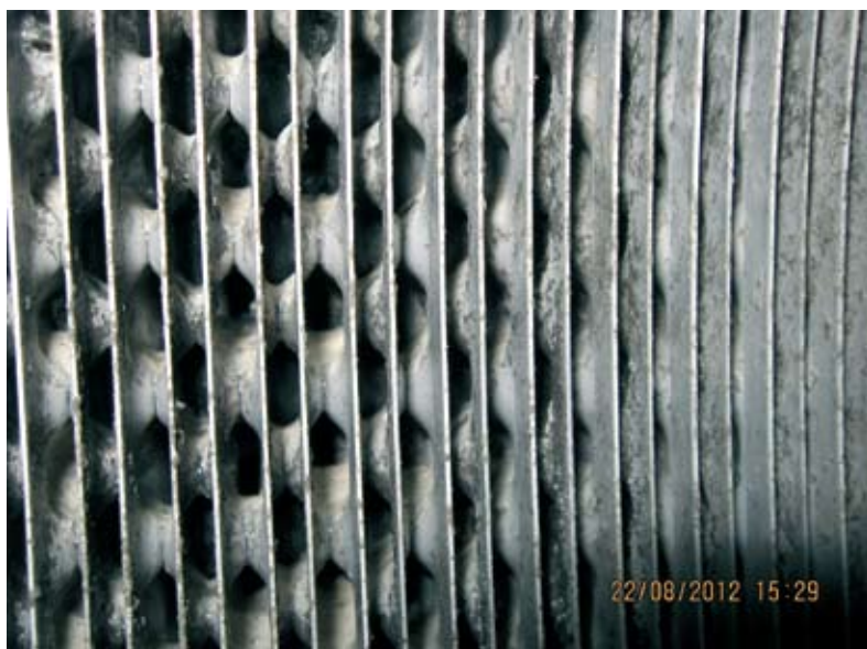
Rys. 16. Widok kanałów bezpośrednio po zakończeniu czyszczenia, przed końcowym płukaniem wodą
