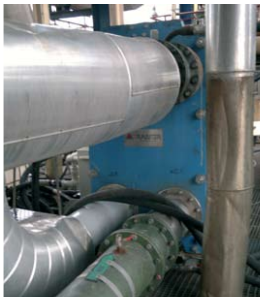
Rys. 4. Wymiennik firmy TRANTER przeznaczony do czyszczenia
