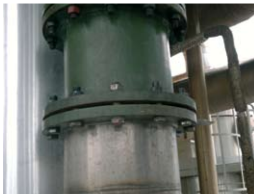
Rys. 8. Wykonanie przekładek
