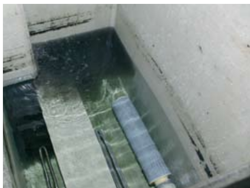
Rys. 13. Odmulanie wymiennika
